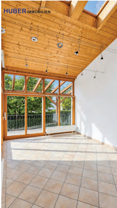
wintergartenartiger Anbau Istzustand
