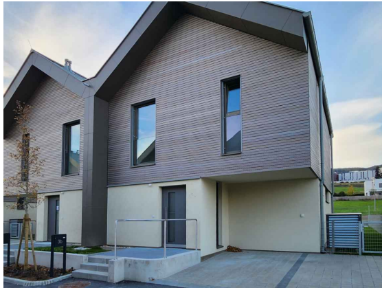
Ansicht von der Privatstraße
